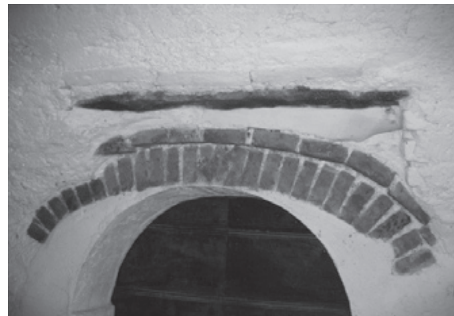
Foto 5 - Finestra, Casa Zinoni, interno. Gazzane di Roè Volciano
